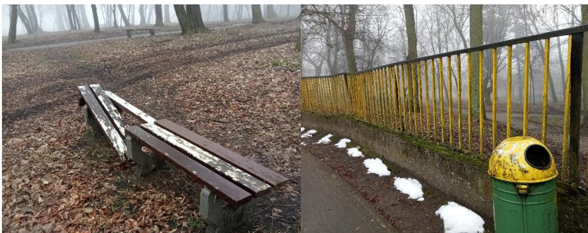
Ryc. 19. Elementy wyposażenia parku miejskiego w złym stanie technicznym
