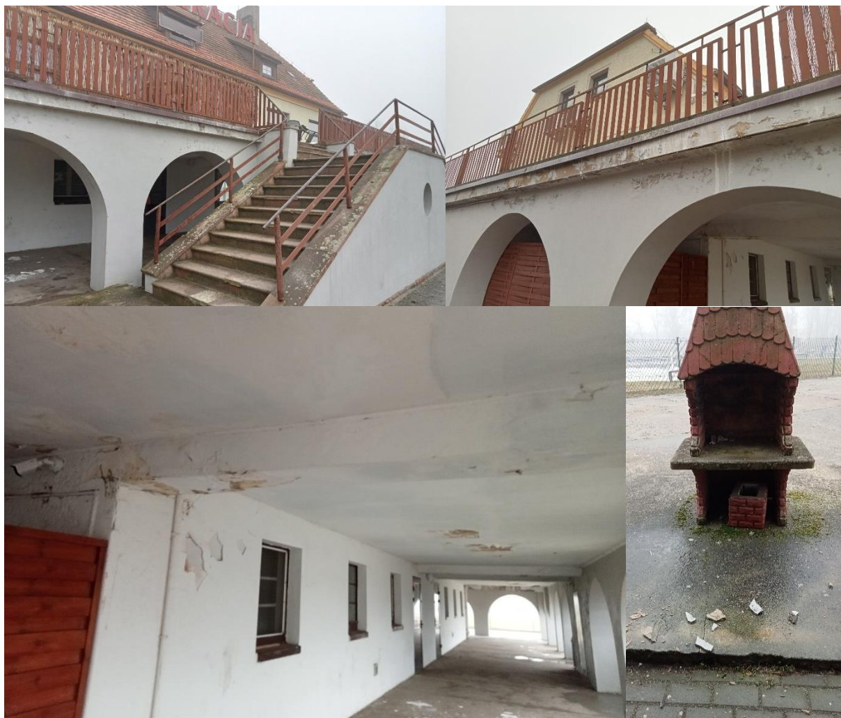
Ryc. 17. Budynek Moreny i jego otoczenie
