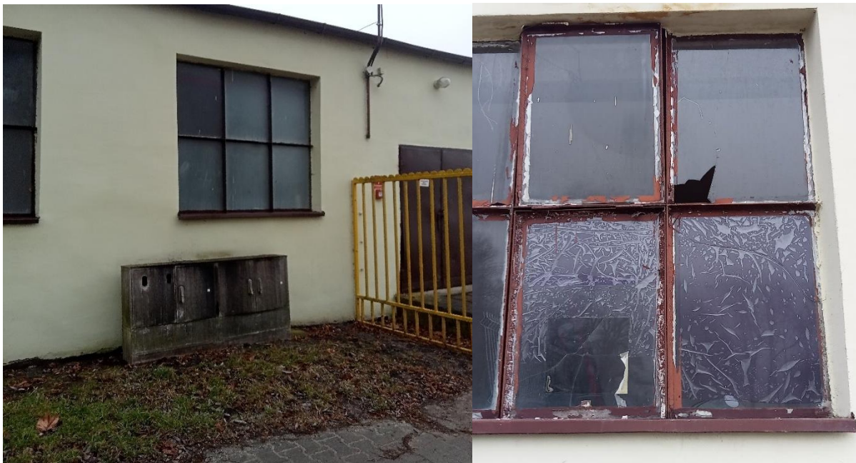
Ryc. 18. Budynek techniczny basenu
