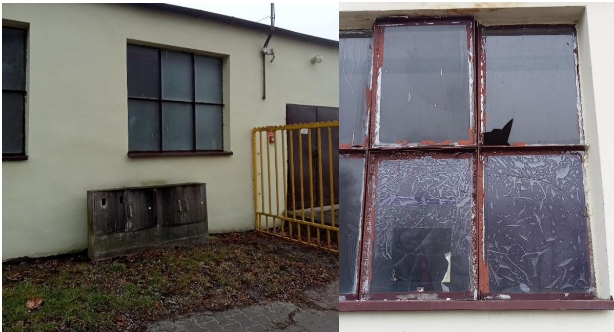
Ryc. 18. Budynek techniczny basenu
