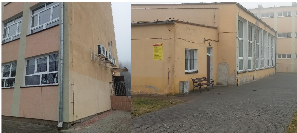
Ryc. 22. Budynek Szkoły Podstawowej im. Adama Mickiewicza w Żerkowie
