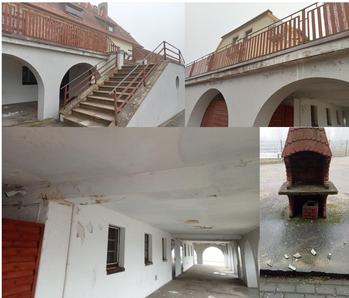
Ryc. 17. Budynek Moreny i jego otoczenie
